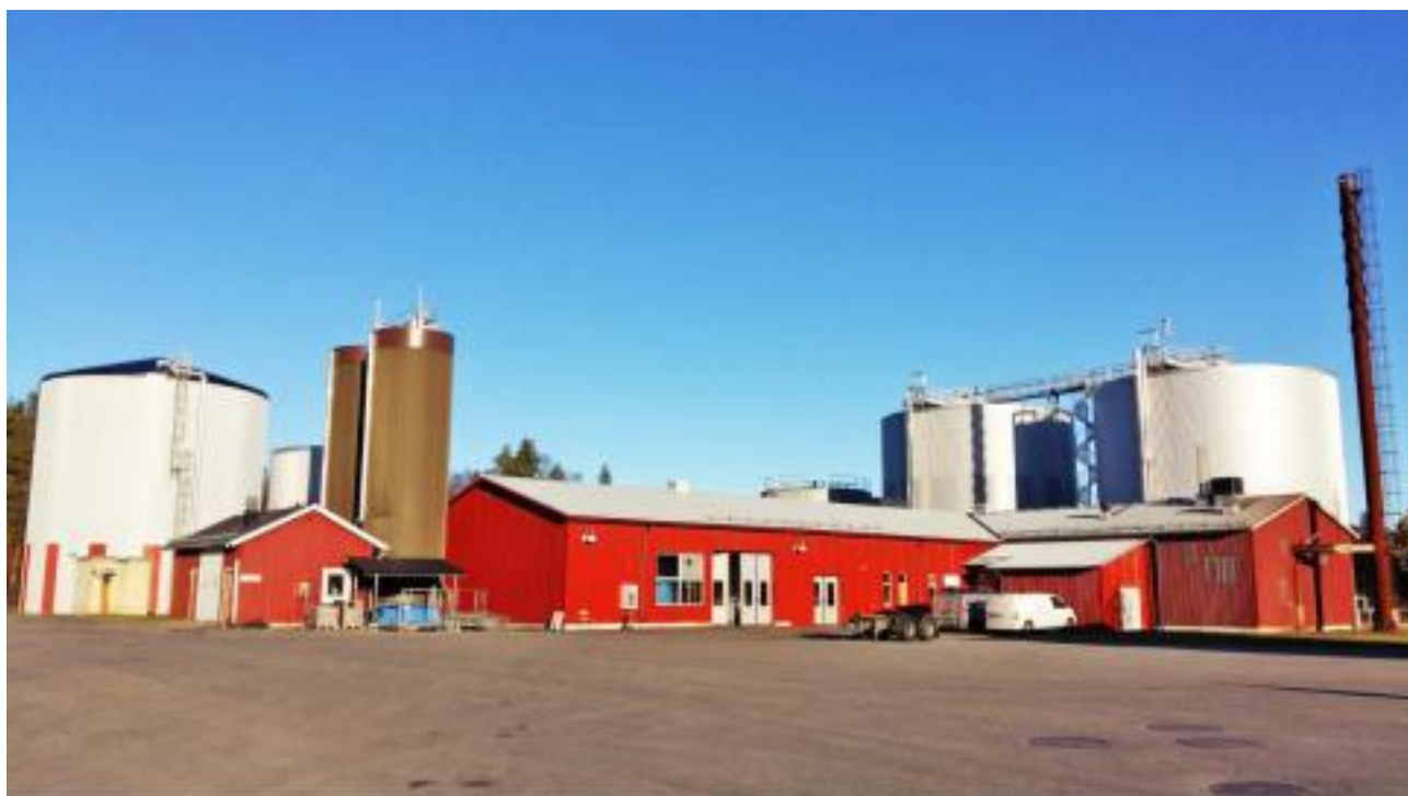
Oczyszczalnia ścieków Biomar® z 2 reaktorami Biomar AWR (po prawej) i reaktorem Biomar OSB (po lewej)
